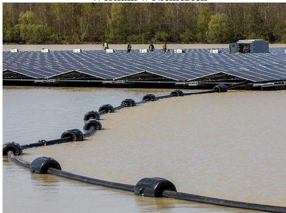
Rysunek 7 Pływająca farma fotowoltaiczna na zbiorniku Silberseen und Schmaloer Heide w Nadrenii Północnej Westfalii w Niemczech
