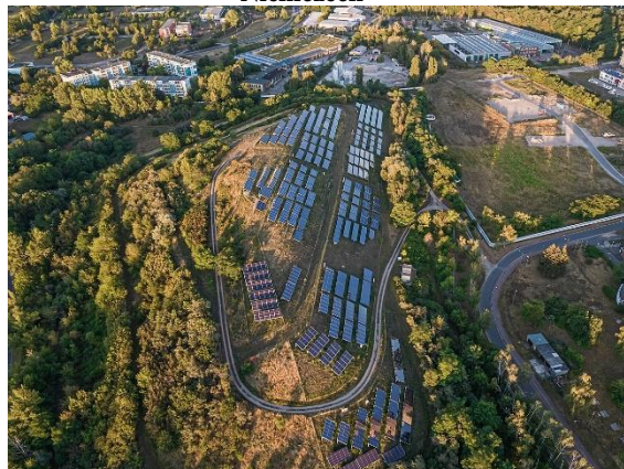
Rysunek 8 Instalacje fotowoltaiczne na dawnym składowisku odpadów we Frankfurcie nad Odrą w Niemczech
