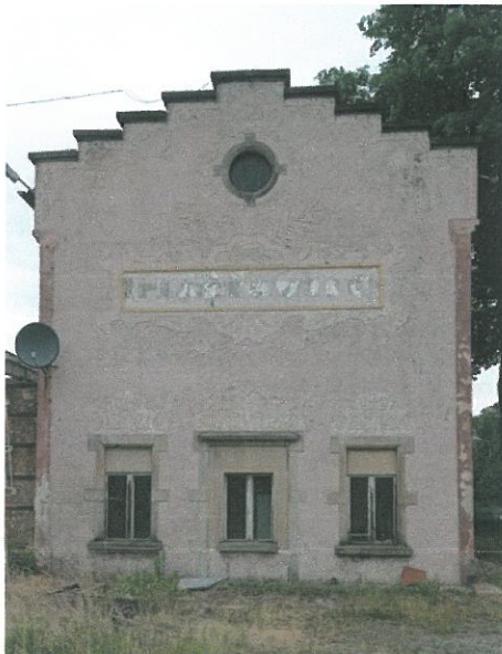
2. Widok ściany szczytowej
