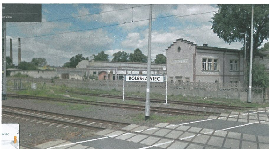
3. Widok terenu inwestycji od strony torów kolejowych
