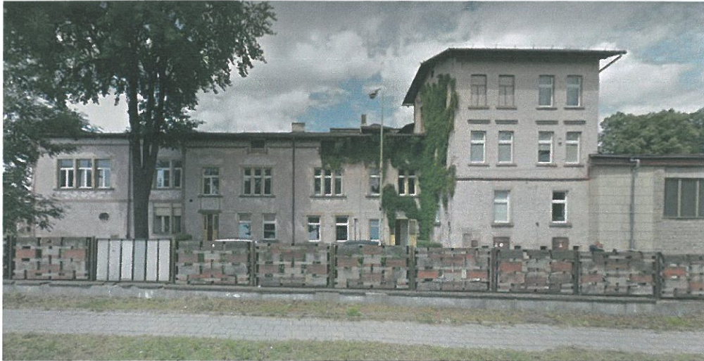
1. Widok budynku od ulicy
