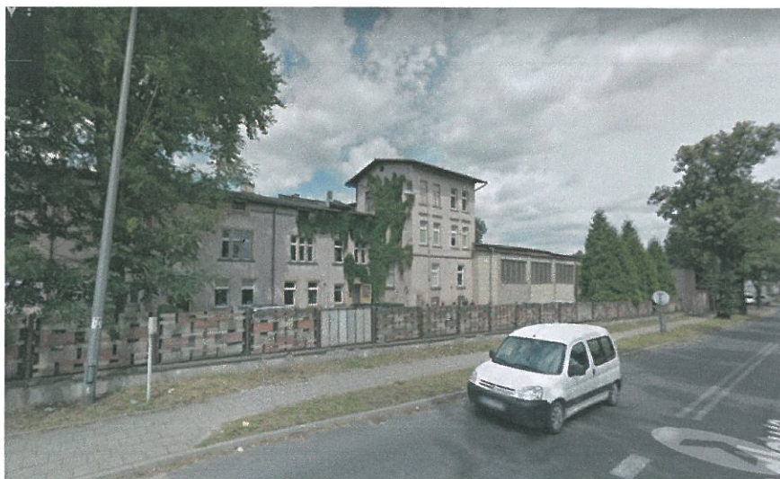
2. Widok od ul. Modłowej (na pierwszym planie – budynek zabytkowy + hala przemysł)
