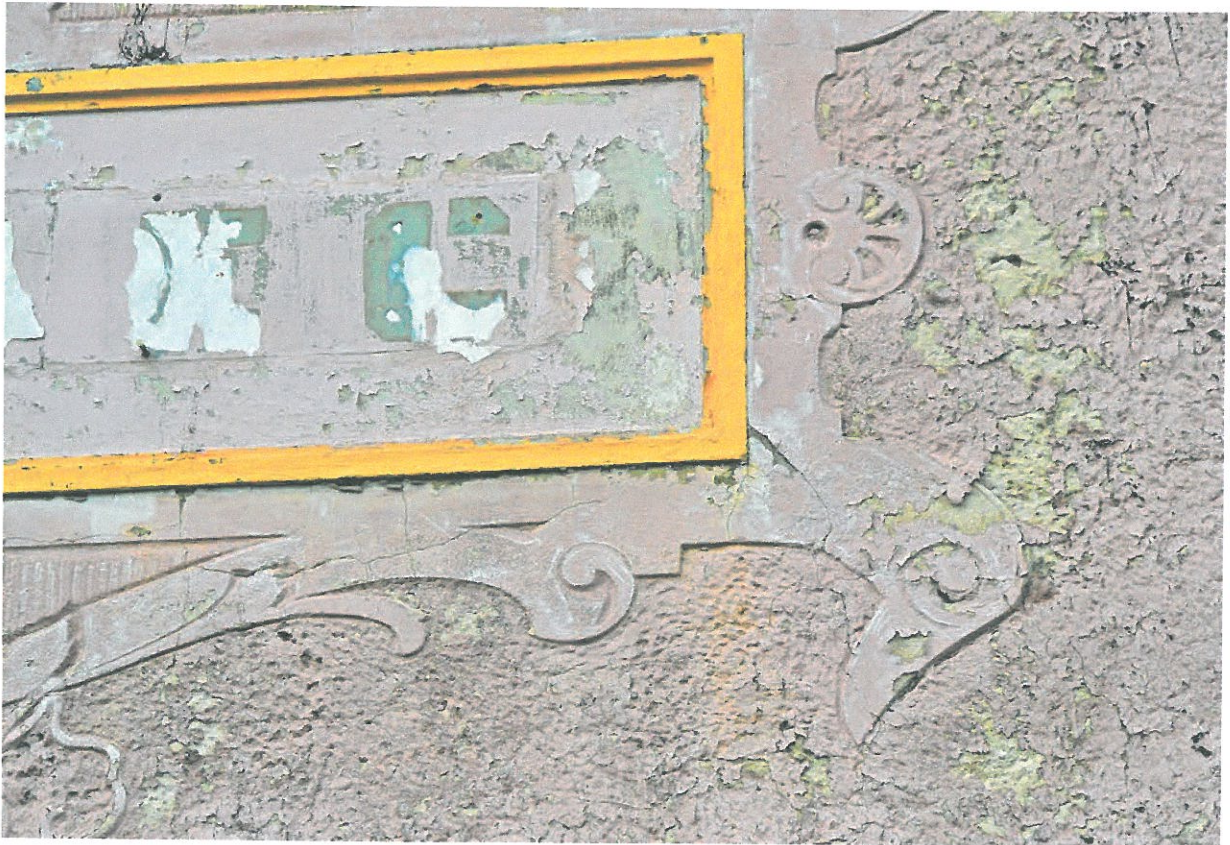
Fot. 25, 26. Elewacja południowa – sgraffito pod okulesem.
