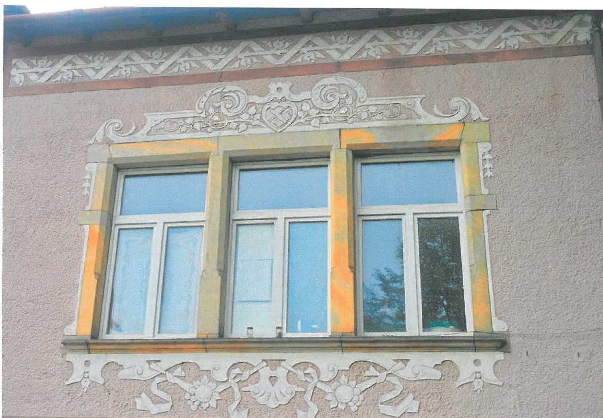
Fot. 22. Elewacja wschodnia - sgraffita w części południowej.
