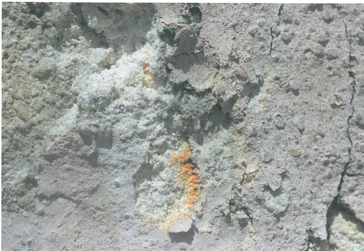
Fot. 41. Odkrywka w obrębie detalu sgraffita. – c. d.
