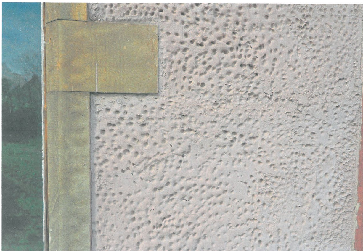
Fot. 12. Wtórne uzupełnienie tynku w przyziemiu elewacji południowej.
