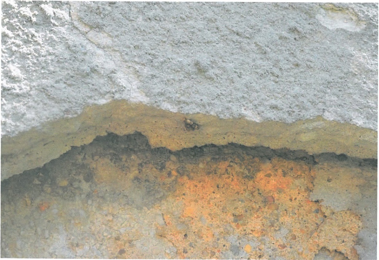
Fot. 45. Tynki elewacji zachodniej.
