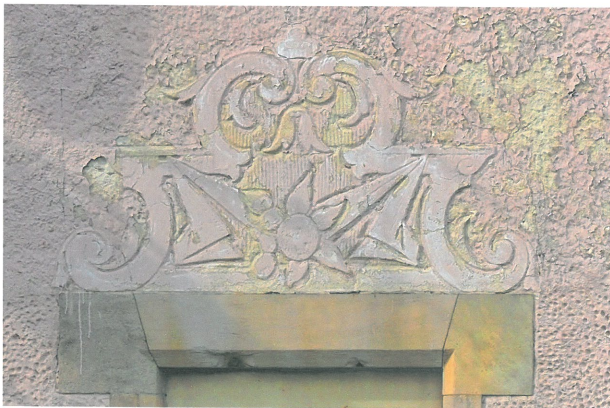
Fot. 31, 32. Elewacja południowa – sgraffita nad oknami parteru – c.d.
