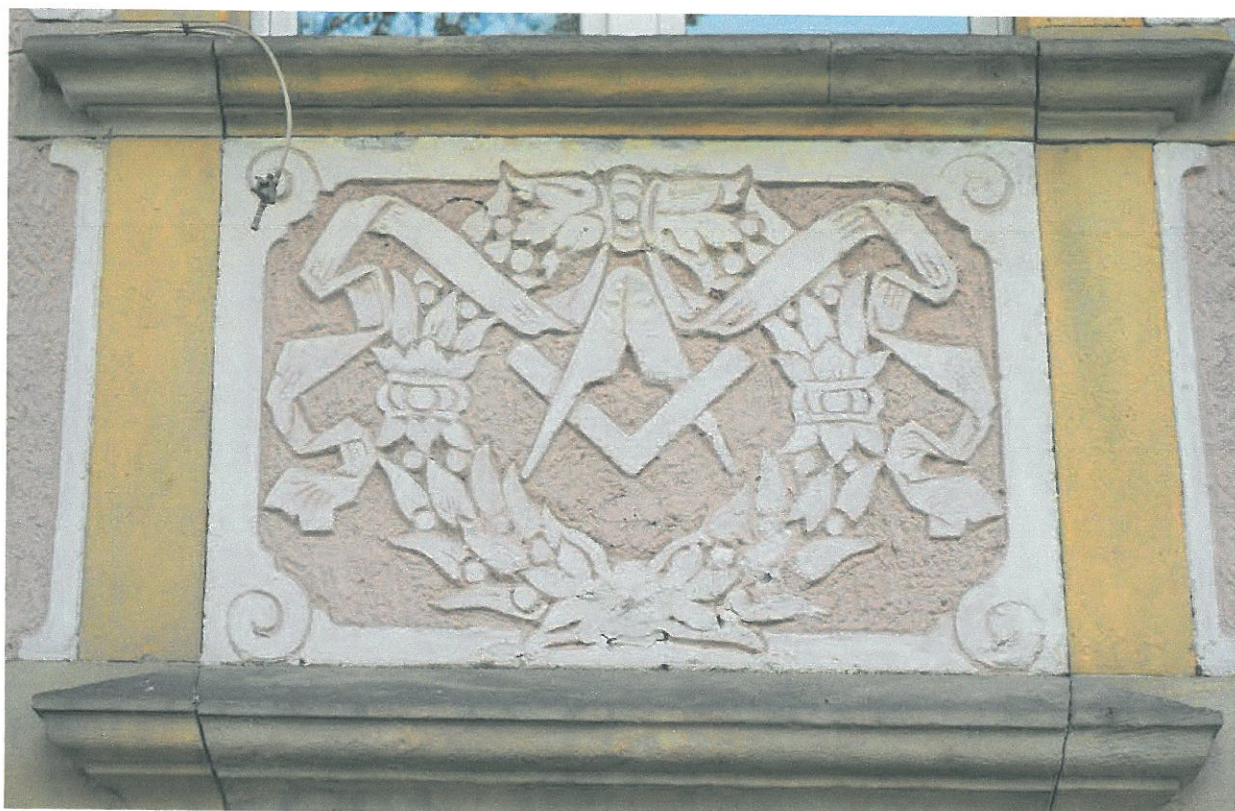
Fot. 21. Elewacja wschodnia – sgraffito nad południowym wejściem do budynku.
