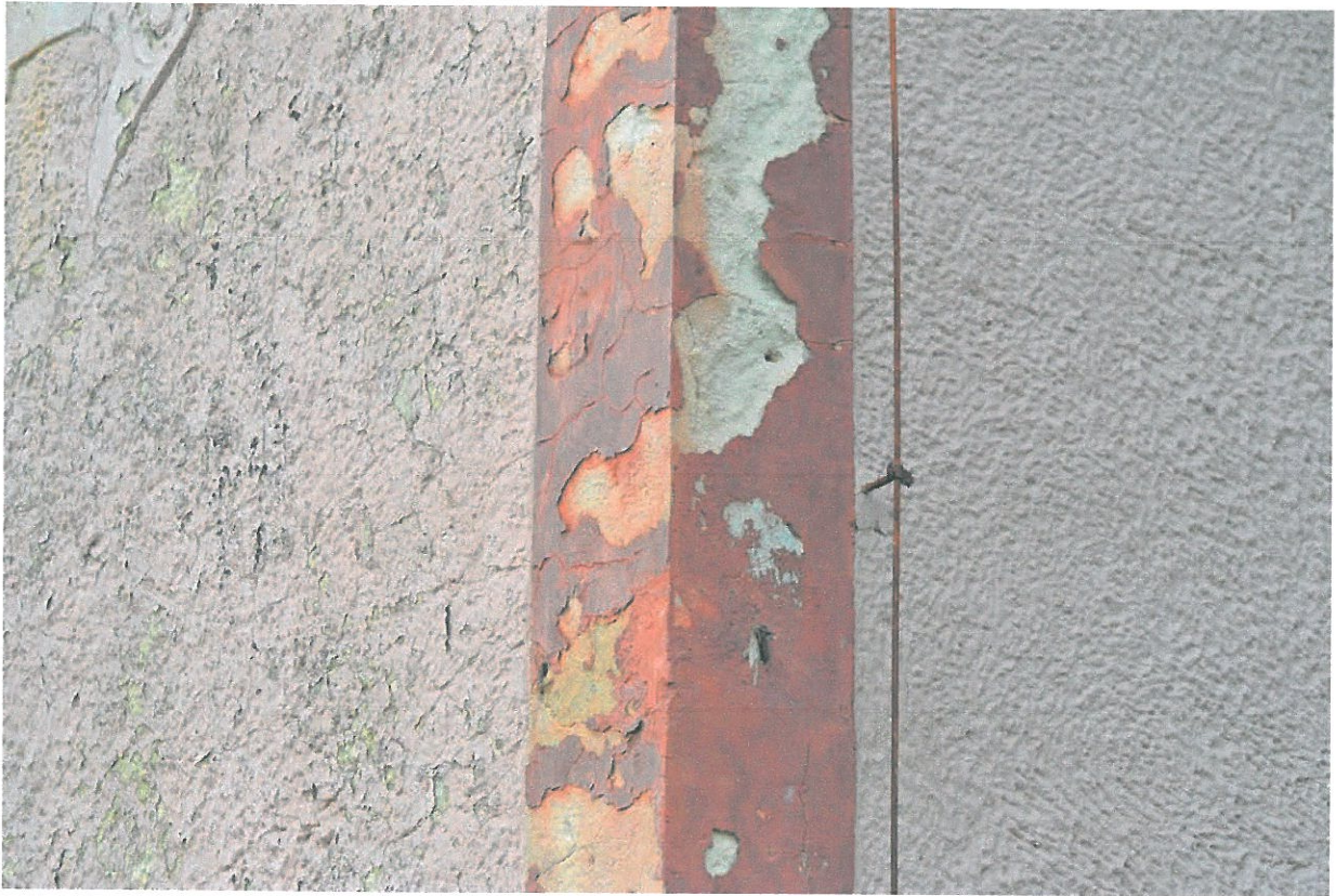
Fot. 35. Tynk w narożniku elewacji południowej i zachodniej.
