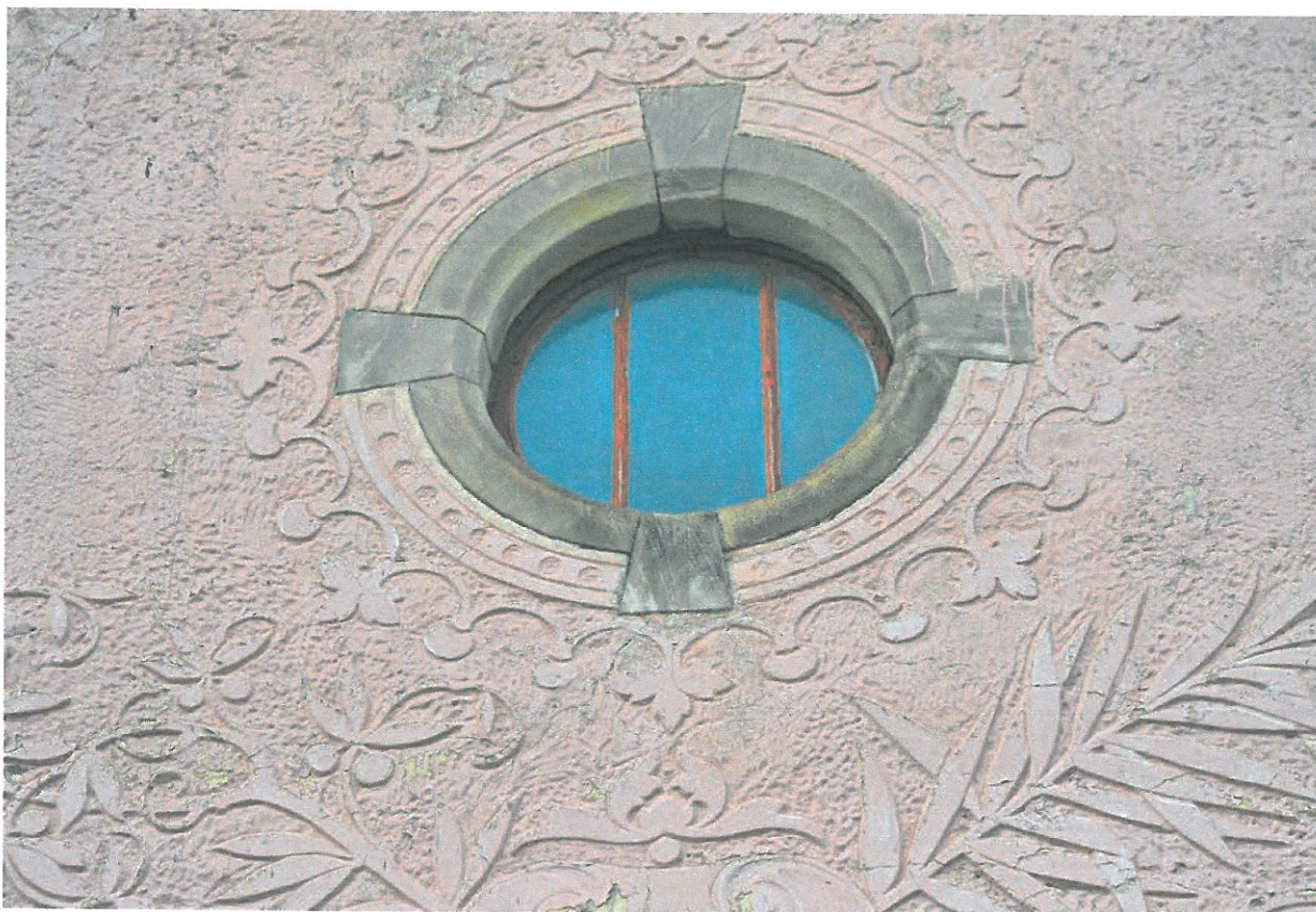
Fot. 27. Elewacja południowa – zbliżenie za sgraffito wokół okulusa.
