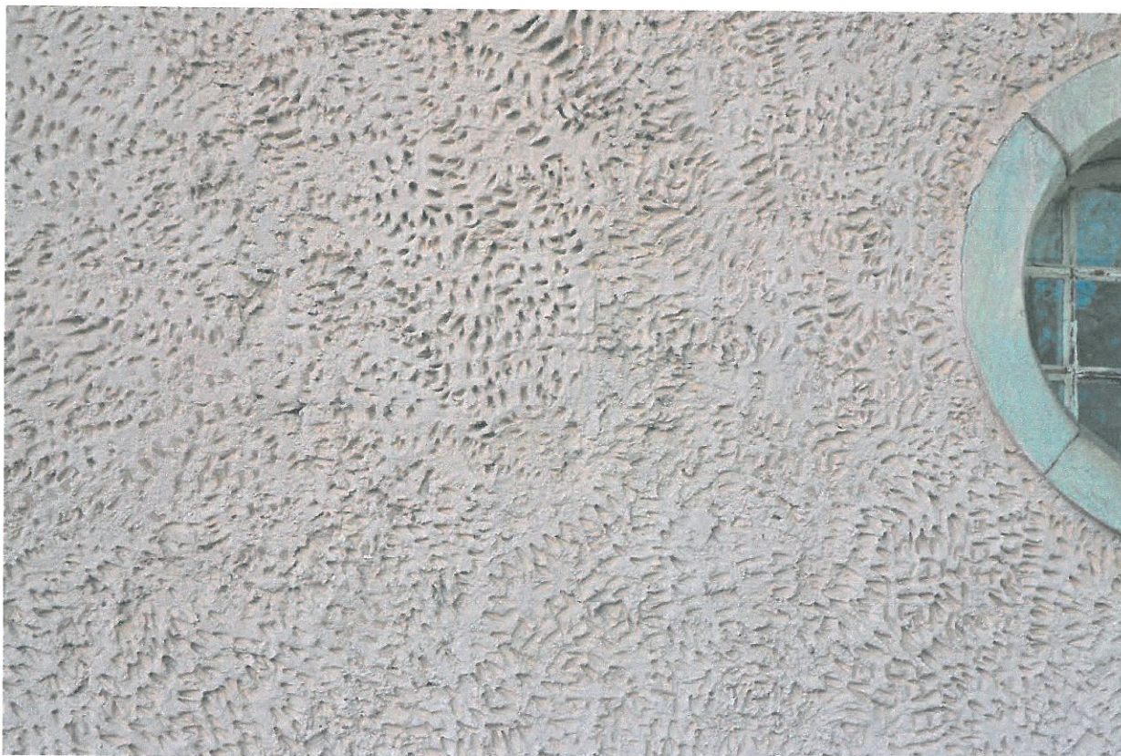
Fot. 13. Wtórne uzupełnienie tynku w przyziemiu elewacji wschodniej.
