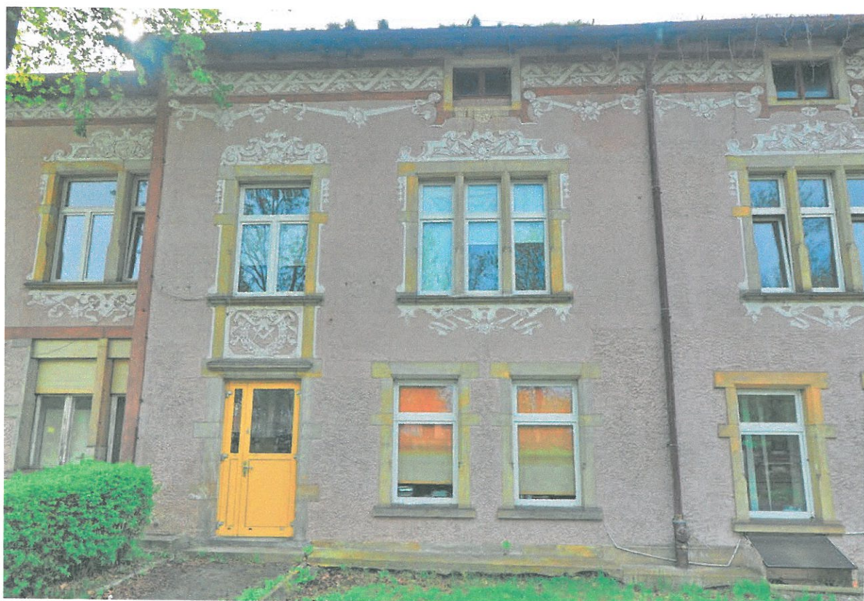
Fot. 9, 10. Elewacja wschodnia – część centralna.
