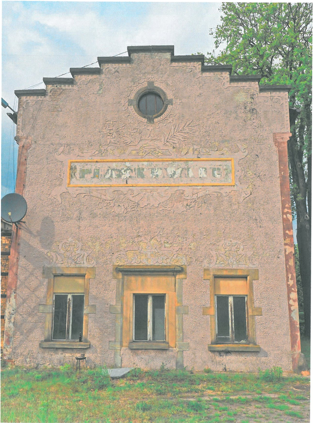
Fot. 7. Elewacja południowa.
