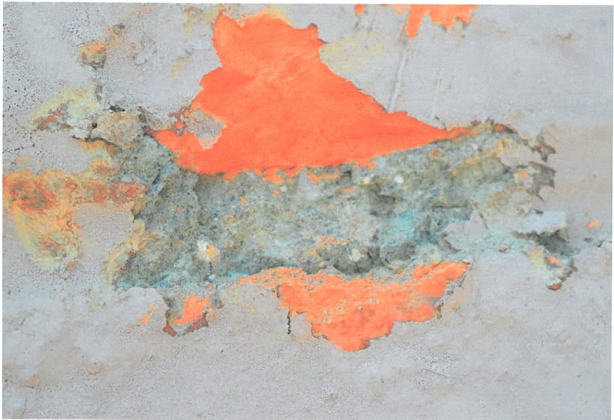
Fot. 36. Odkrywka w obrębie muru ceglanego.
