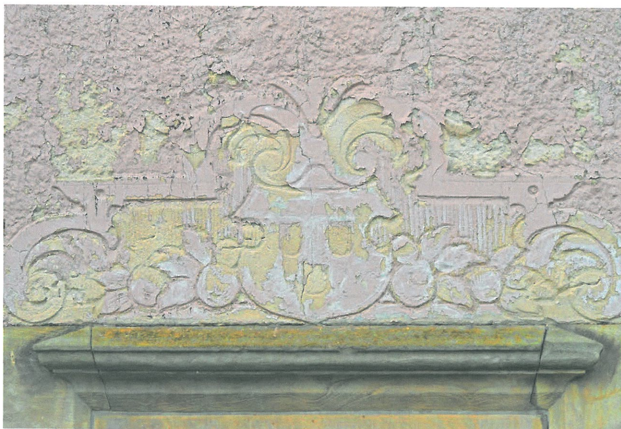
Fot. 29, 30. Elewacja południowa – sgraffita nad oknami parteru.
