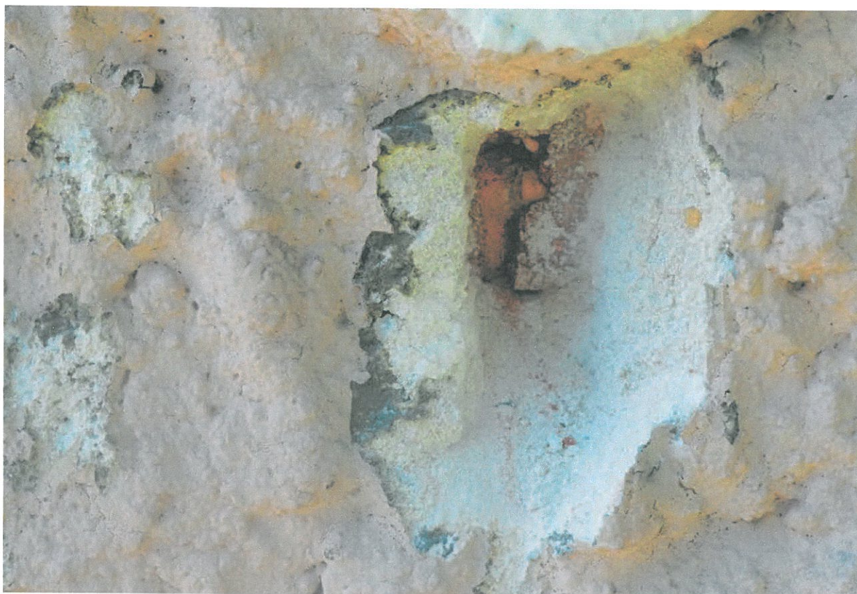
Fot. 37, 38. Odkrywki w obrębie tła sgraffita (tynku oryginalnego).
