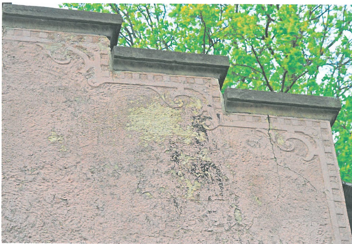
Fot. 28. Elewacja południowa – sgraffito pod piaskowcowymi gzymsami wieńczącymi elewację.
