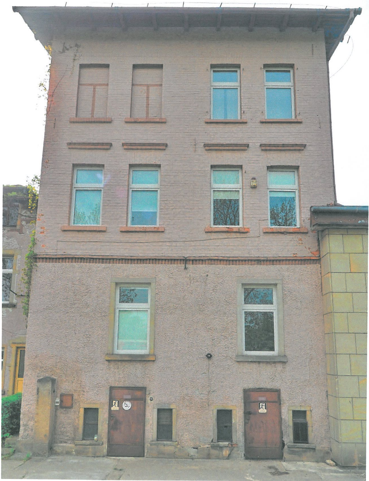
Fot. 8. Elewacja wschodnia – część północna.
