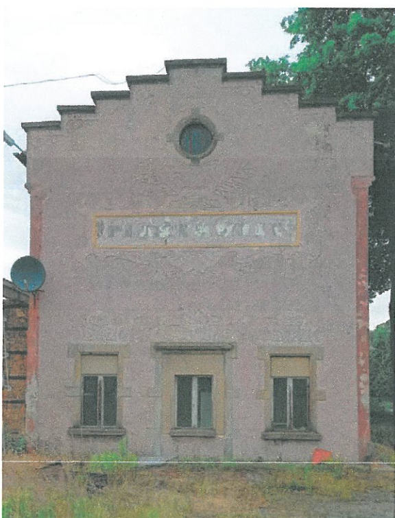
2. Widok ściany szczytowej
