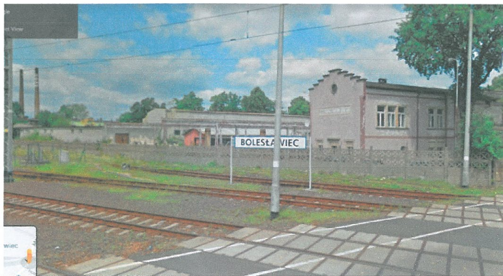
5. Widok terenu inwestycji od strony torów kolejowych
